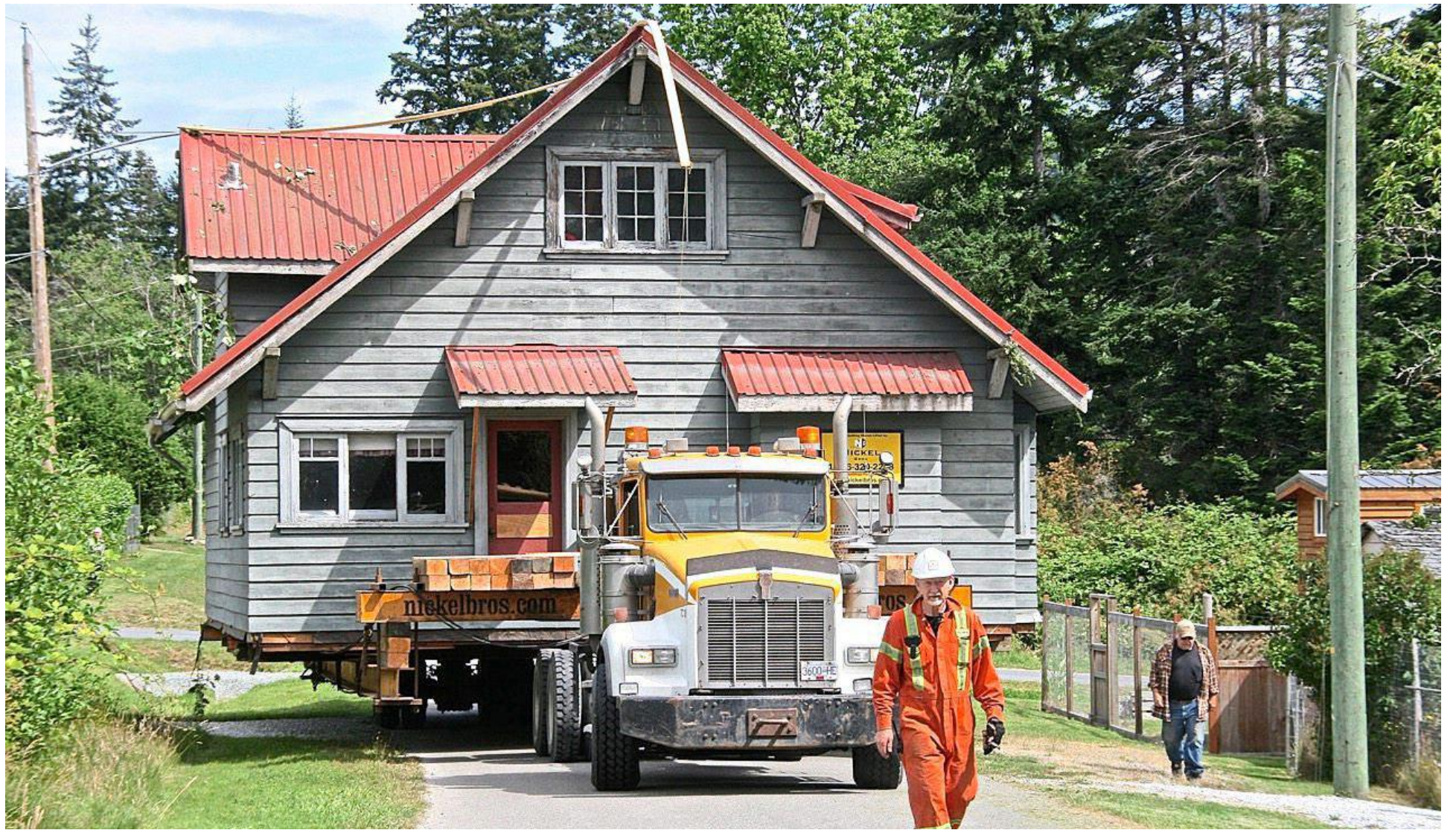
Ein Haus zieht um: In Kanada und den USA ist es durchaus üblich, dass ein Gebäude auf einen Truck gepackt wird und durchs halbe Land reist. Möglich machen dies Experten von Spezialfirmen wie Nickel Bros, die auch mehrstöckige Immobilien durch enge Passagen bugisieren. Fotos: Nickel Bros
